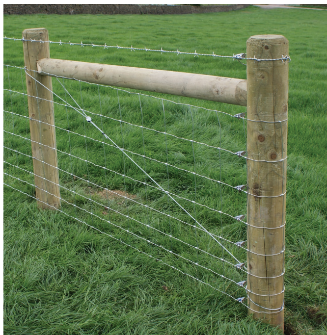
FPAK - Instalacja na słupku typu H
