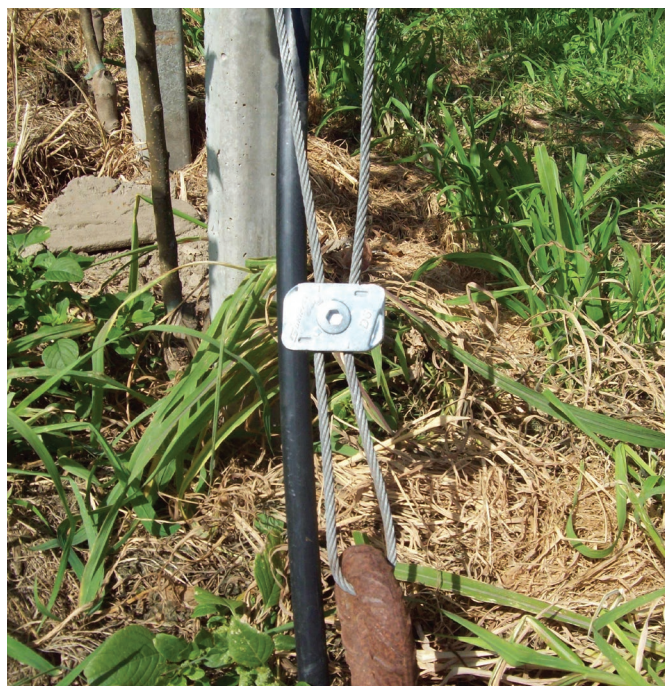
DPAK zamontowany na betonowym słupku w kształcie pętli.
