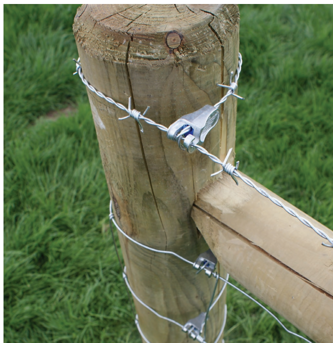
Złączka T-Clip2 użyta do zakończenia drutu kolczastego
