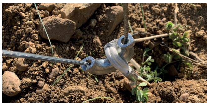
U góry. Lina stalowa zamontowana a na szczycie drewnianego słupka. Na dole. Naparstek.
