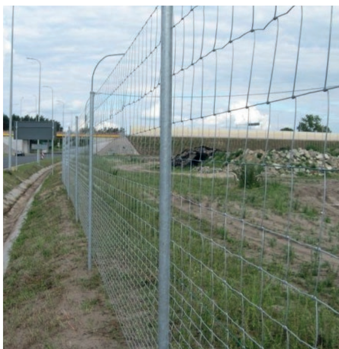
Fencing Pin zamontowana przy autostradzie
