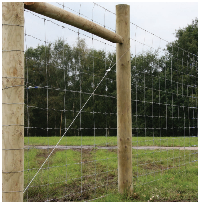
Zestaw FPAK użyty do usztywnienia zakończenia ogrodzenia
